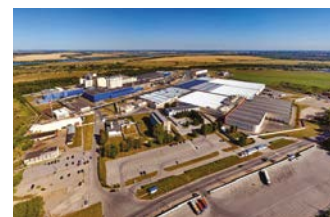
Завод «Проктер энд Гэмбл», г. Новомосковск
