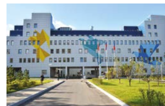
Перинатальный центр, г. Щелково
