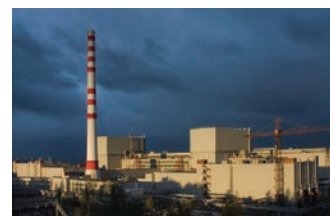
Ленинградская АЭС, г. Сосновый Бор
