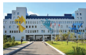
Перинатальный центр, г. Щелково
