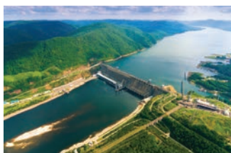
Красноярская ГЭС, г. Дивногорск
